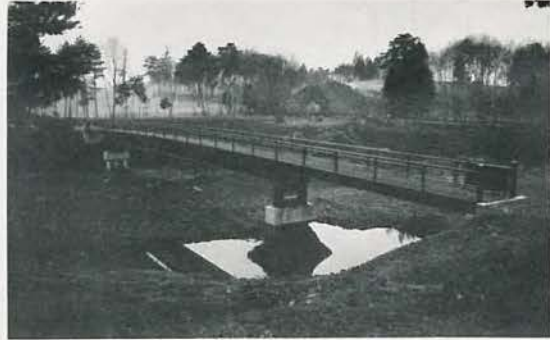
黄金溜新橋完成(昭和57年 3月)
