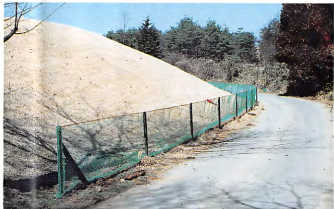
防球ネットの張替え作業が終了した黄金1番ロングホール
