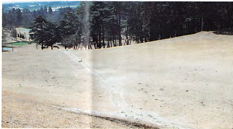
フェアウェイの排水工事が完了した南18番ミドルホール
