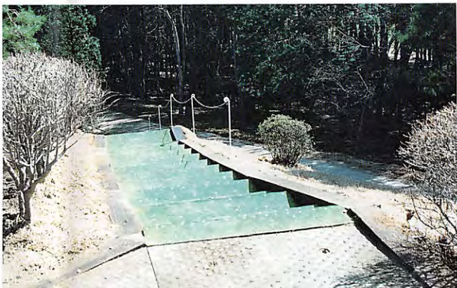
階段の改修作業が終了した黄金5番ミドルホール
