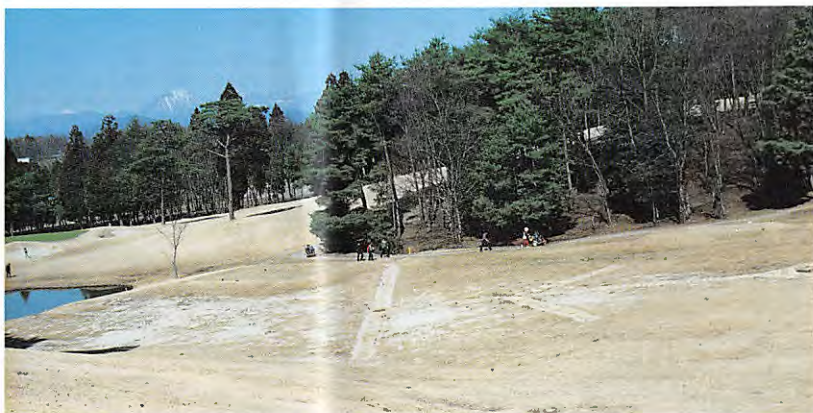
フロントティーグラウンド前の排水工事が完了した北13番ミドルホール
